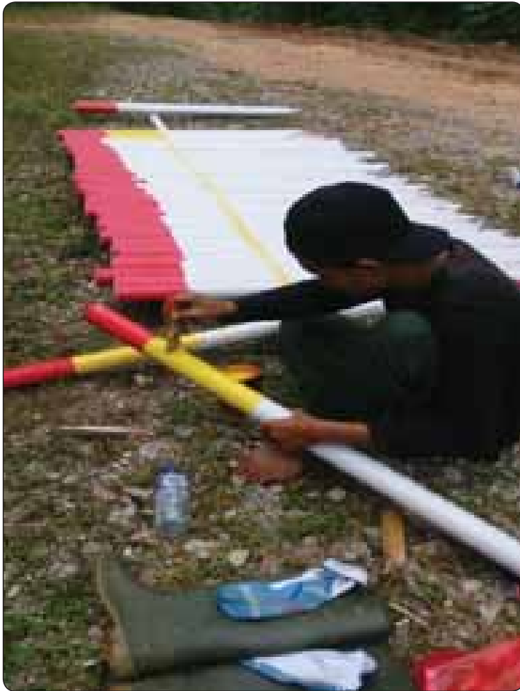
Gambar 7. Pemberian cat atau warna penanda untuk patok permanen
